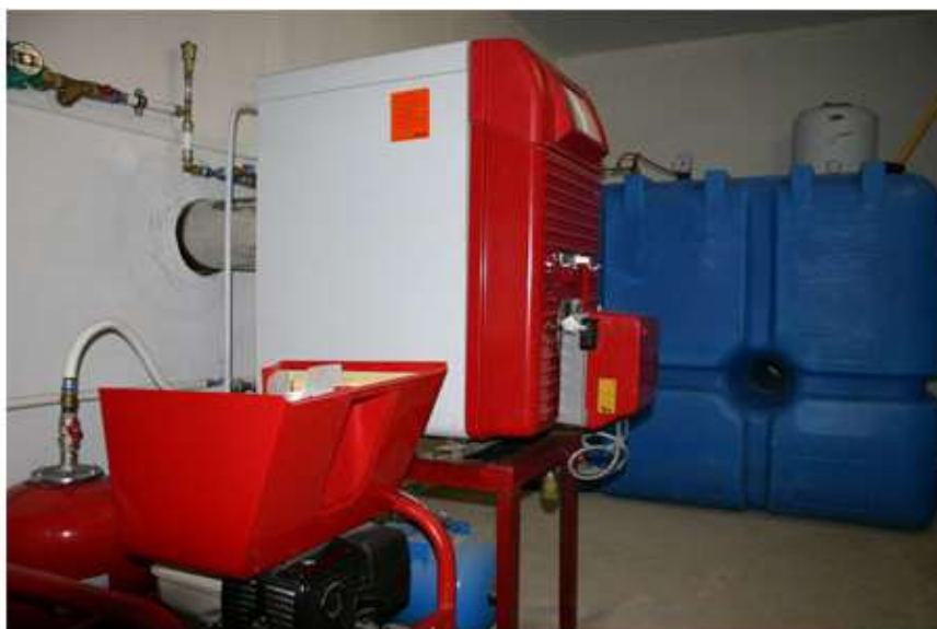
Рис. 6.18. Помещение 1. Склад хранения дизельного топлива
